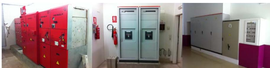
Dotación de centro de transformación de abonado para una potencia aparente de 1230 kva mediante transformadores de potencia de 630 kva de potencia unitaria. Alimentación de media tensión en bucle, con celdas de entrada y salida de línea.
