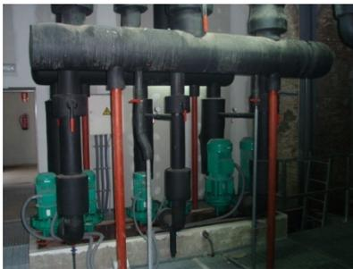
Un Aljibe situado en el extremo de la fachada EsteS que dan servicio a los sistemas contra incendios (Bie,s) y agua sanitaria a través de sistemas de bombas de impulsión, conducciones y llaves de corte.
