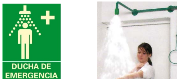
Figura 40. Señalización y uso de duchas
