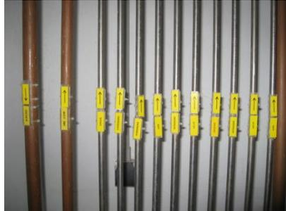
*Las tuberías por las que circulan fluidos peligrosos estarán identificadas y señalizadas, especialmente en las válvulas y puntos de regulación y control a fin de evitar posibles errores o confusiones.*
